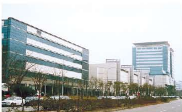
現代化高科技廠房
